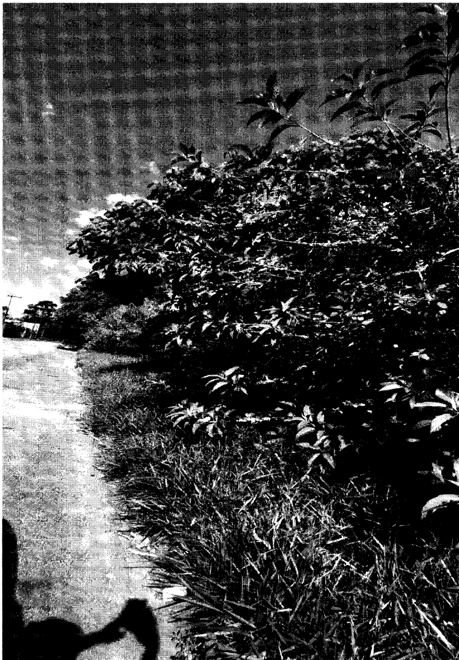
CAPINAÇÃO DE CABEÇAS DE GUIAS E RASPAGEM DE SARJETAS na Rua Francisco Vilela, na altura do número 142, Ponte Grande- Mogi das Cruzes.
